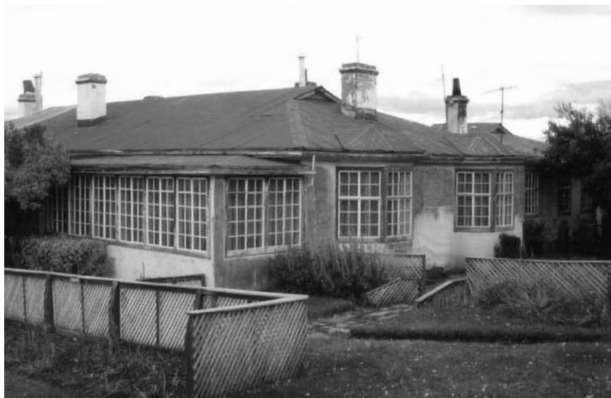
Aspecto de la Casona de Administración de estancia “Cerro Guido”. En ambas instalaciones funciona actualmente el Hotel Estancia Cerro Guido
